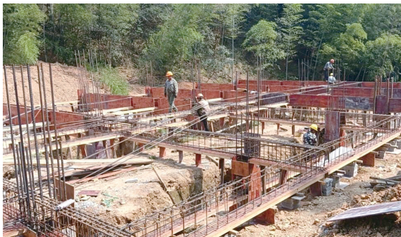
▲黄塘元坳中医药康养项目施工现场
