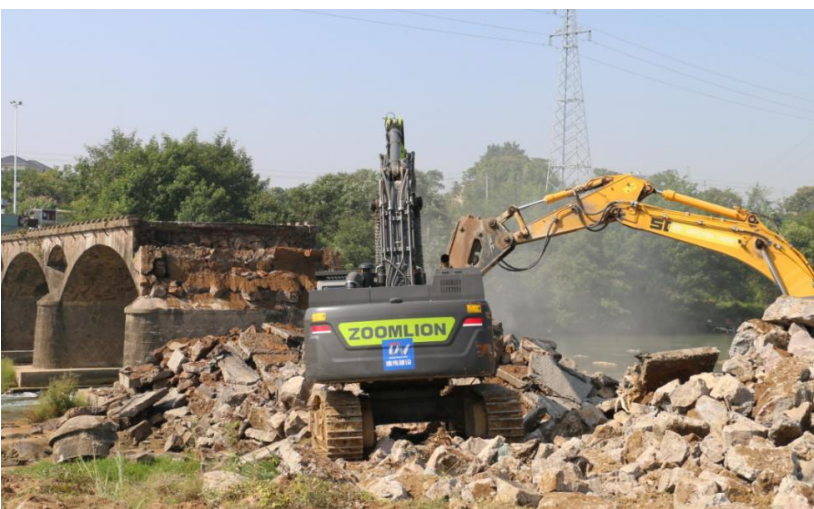
图为拆除现场
