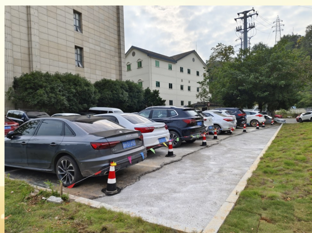
▲修复破损地面,方便群众通行。
