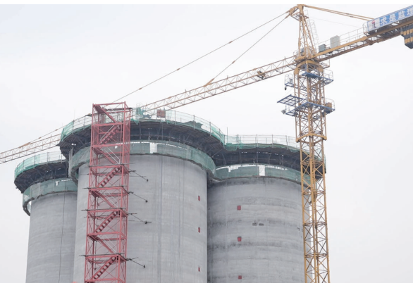
图为建设现场
