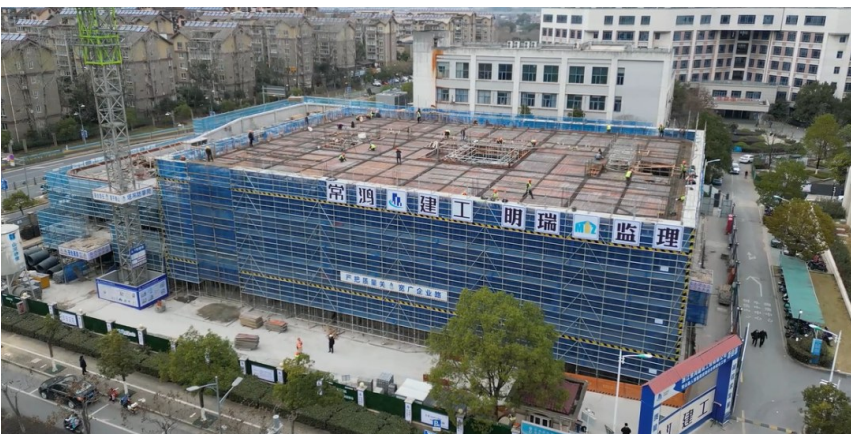
图为县人民医院后勤综合楼建设项目现场
