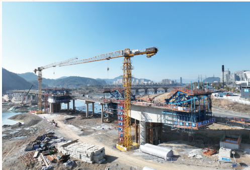
常山江航电枢纽项目(常山段)
