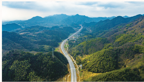
351国道龙游横山至开化华埠段公路工程(常山段)
