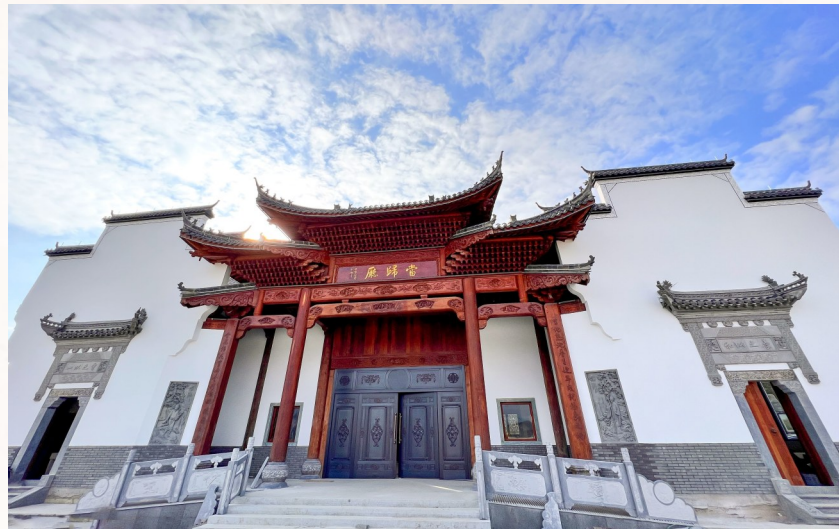
▲元坳中医药康养项目一期工程
