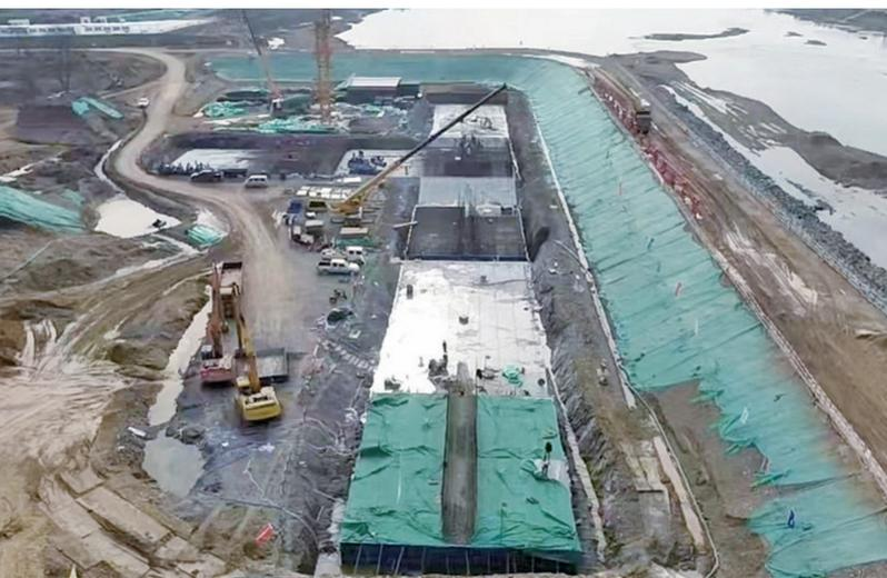
钱塘江中上游常山江(辉埠—港口)航电枢纽项目全长约51.1公里,主要新建6座航电枢纽,改建桥梁8座,新建服务区2处、锚地5处,建设相应的导助航设施、信息化(智慧航道)等配套工程,项目总投资90.3亿元。在常山段,200多名施工人员在招贤枢纽、长圩大桥等建设现场,进行泄洪闸、导流墙、桥梁墩柱和主桥挂篮施工。目前,累计完成投资9.77亿元,总体形象进度16.8%。
